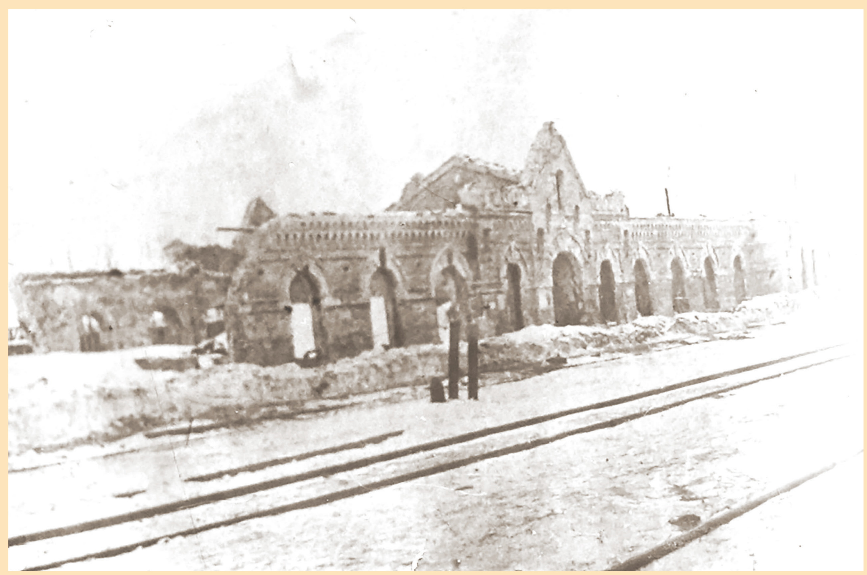
Разрушенный вокзал станции Сухиничи-Узловые. 1942 год.
